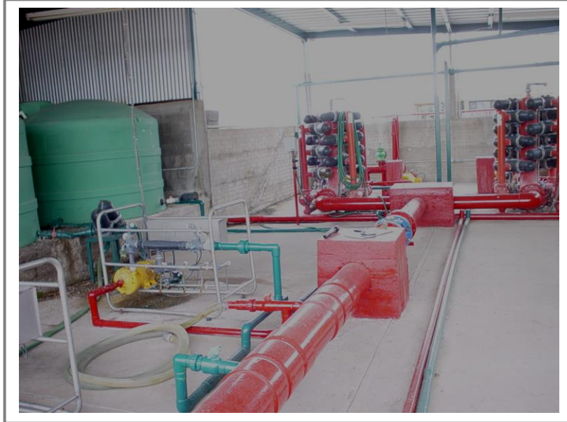
Fotografía que muestra el cabezal de riego con sistema de inyección de fertilizantes y ácidos.
